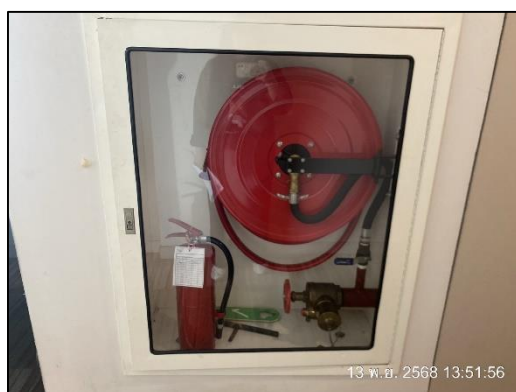
ภาพที่ 28 ตู้เก็บสายฉีดน้ำดับเพลิงพร้อมอุปกรณ์ (FHC)
