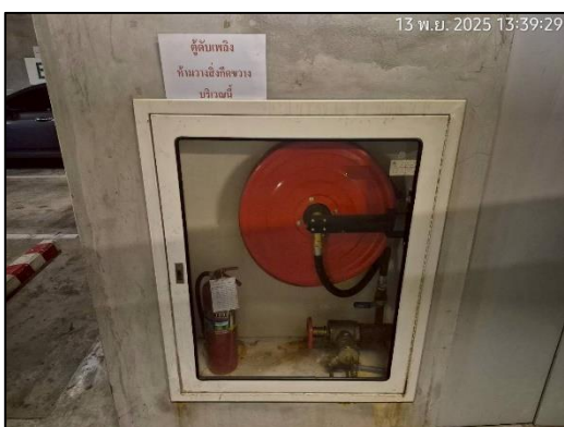
ภาพที่ 28 ตู้เก็บสายฉีดน้ำดับเพลิงพร้อมอุปกรณ์ (FHC)
