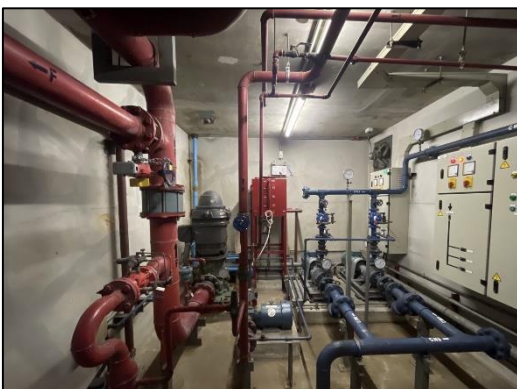
ภาพที่ 26 เครื่องสูบน้ำดับเพลิง
